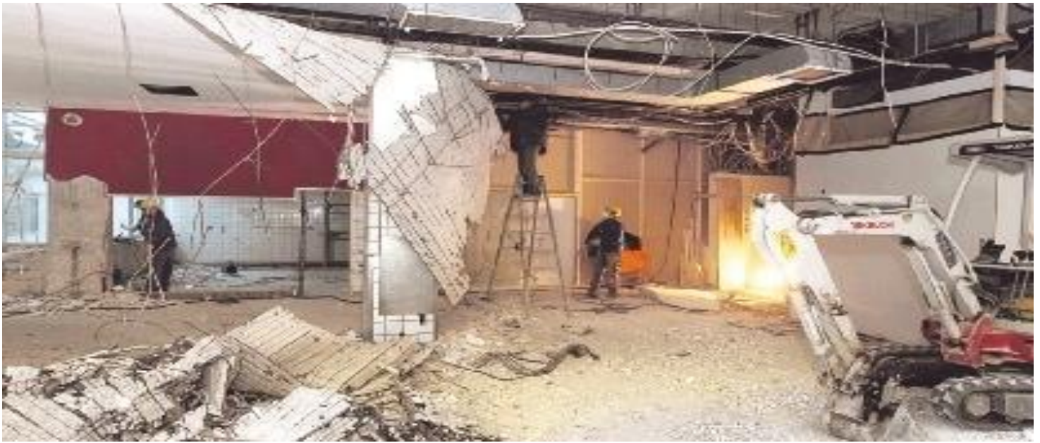
Baustelle Klinikküche Löwenstein: Bis zum 6. Dezember sollen Handwerker und Bagger verschwinden und Köchen Platz machen.
